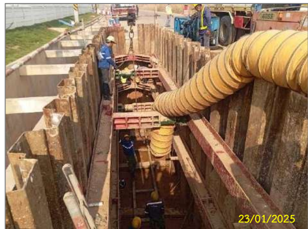
การปฏิบัติงานในพื้นที่อับอากาศ
