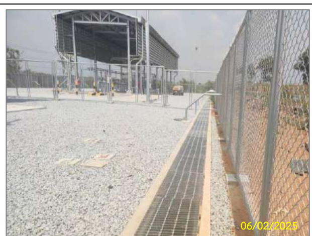
รูปที่ 2-26 รางระบายน้ำโดยรอบพื้นที่สถานีควบคุมและปรับลดความดันก๊าซธรรมชาติ (Gate Station)
