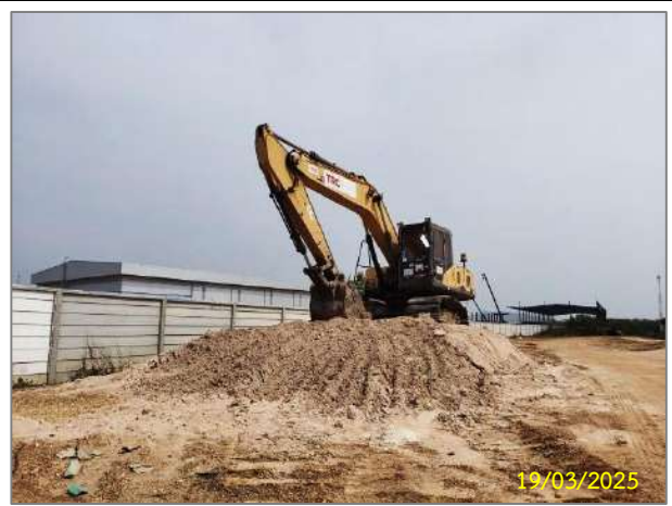
รูปที่ 2-17 การจัดพื้นที่กองดินห่างจากแหล่งน้ำ
