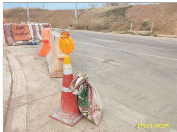
การติดตั้งสัญญาณไฟกระพริบ และไฟแสงสว่างเตือน
