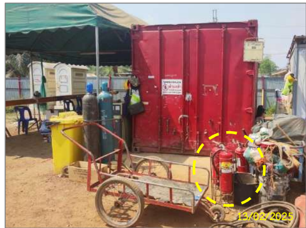
การกั้นเขตบริเวณพื้นที่ที่มีการเชื่อมต่อ พร้อมอุปกรณ์ดับเพลิงชนิดผงเคมี
