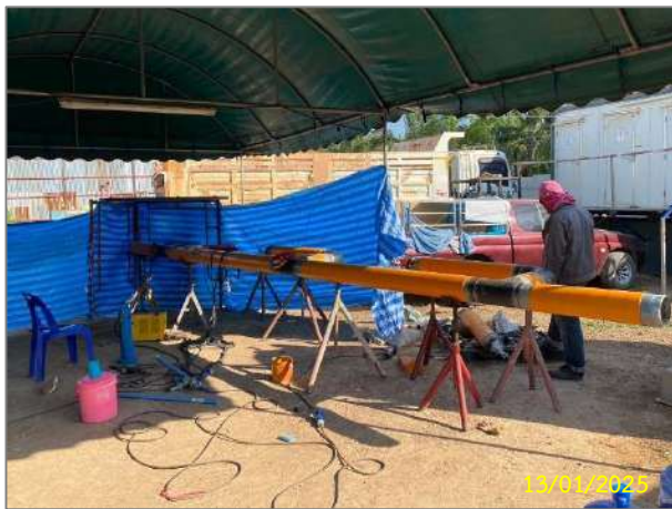
การกั้นเขตบริเวณพื้นที่ที่มีการเชื่อมต่อ พร้อมอุปกรณ์ดับเพลิงชนิดผงเคมี
