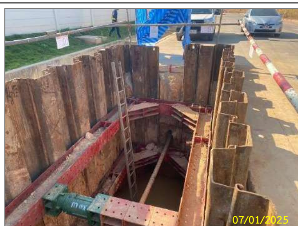
การติดตั้ง Sheet Pile เพื่อป้องกันการถล่มของดิน
