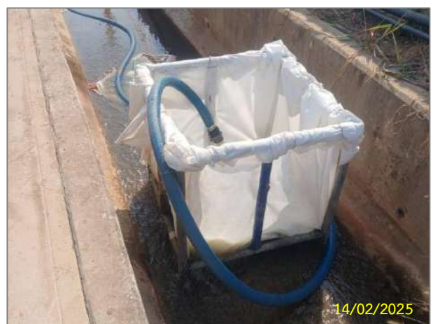
รูปที่ 2-18 การทดสอบท่อด้วยวิธีทางชลสถิติ
