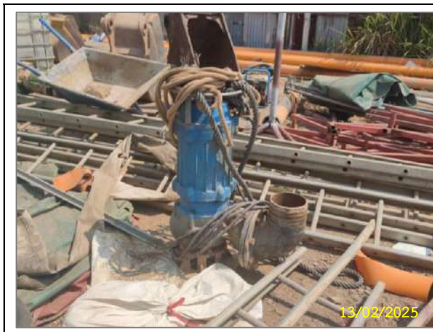
รูปที่ 2-25 การจัดเตรียมเครื่องสูบน้ำสำรองประจำพื้นที่ก่อสร้าง
