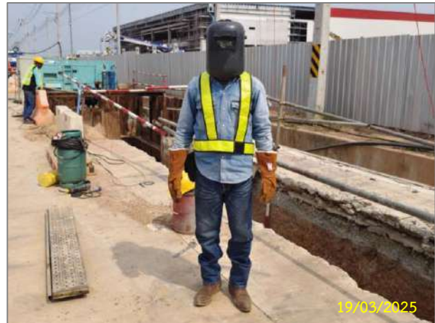
การสวมใส่อุปกรณ์คุ้มครองความปลอดภัยส่วนบุคคล สำหรับงานเชื่อม
