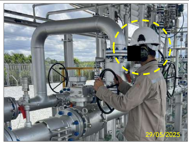
รูปที่ 2-41 ผู้ปฏิบัติงานสวมใส่อุปกรณ์ป้องกันขณะที่ใช้ก๊าซไนโตรเจนใส่อากาศภายในท่อ
