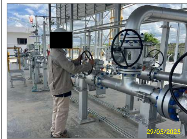
รูปที่ 2-41 ผู้ปฏิบัติงานสวมใส่อุปกรณ์ป้องกันขณะที่ใช้ก๊าซไนโตรเจนใส่อากาศภายในท่อ
