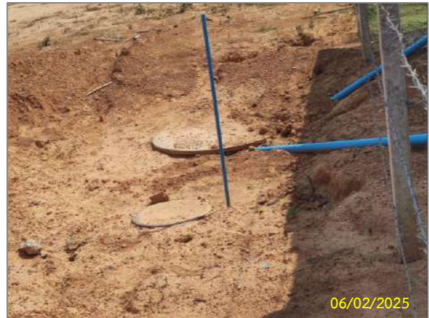
ถังบำบัดน้ำเสียสำเร็จรูปแบบเติมอากาศ
