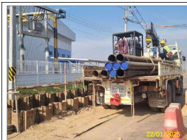
รูปที่ 2-3 การผูกยึดด้วยวัสดุ/อุปกรณ์ระหว่างการขนย้าย
