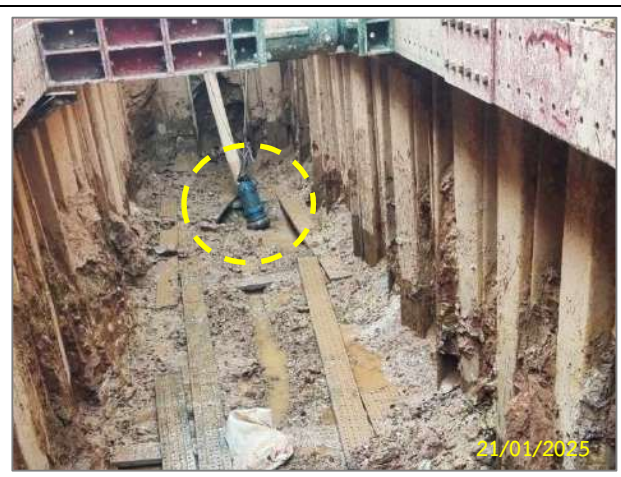
รูปที่ 2-25 การจัดเตรียมเครื่องสูบน้ำสำรองประจำพื้นที่ก่อสร้าง
