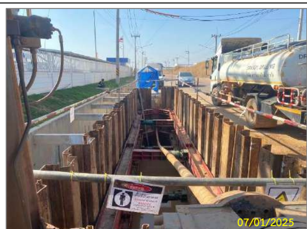
การติดตั้ง Sheet Pile เพื่อป้องกันการถล่มของดิน
