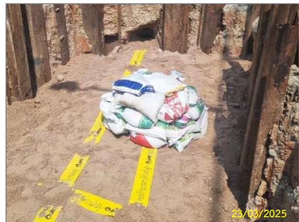
รูปที่ 2-10 การจัดเตรียมถุงกระสอบทราย
